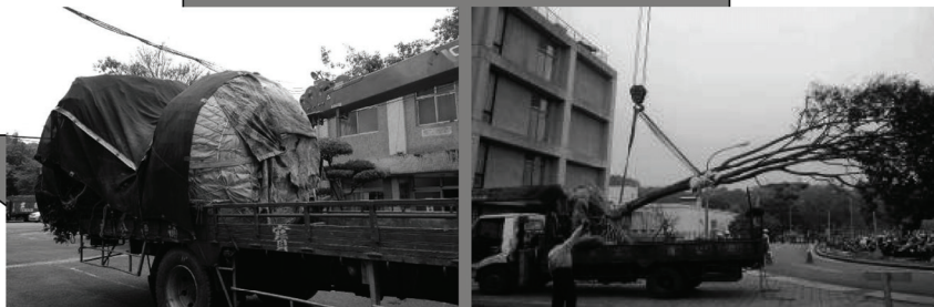
吊掛索具與樹幹之接觸部位應加襯墊包裹保護
