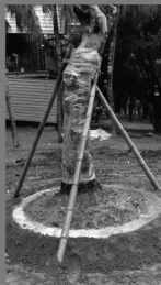
設置集水坑，將土壤壓實
