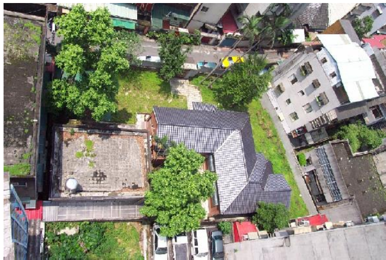
基地俯瞰照片
