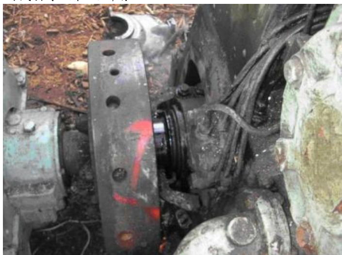
副機引擎曲軸切斷前
