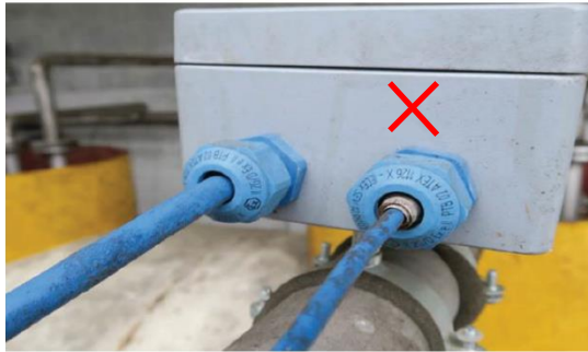
圖 6 電纜封函蓋應與電纜直徑相匹配
