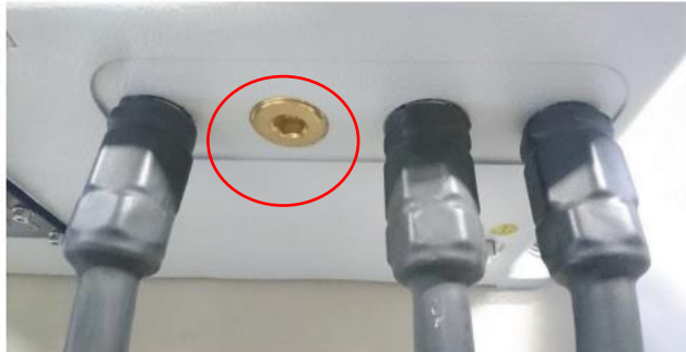
圖 7 未用開孔應以防爆盲塞封閉
