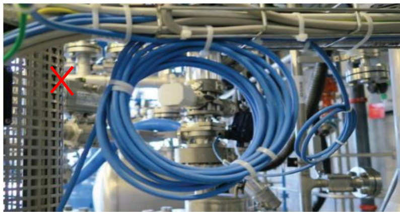
圖 9 本質安全電纜線應與非本質安全電纜線保持 50mm 以上距離
