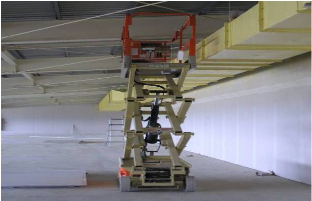
7. 作業高度超過 2 公尺者，採用高空工作車之照片。
